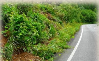
林道の法面の掘り起こし
