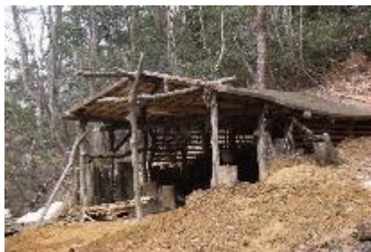
建設中の炭焼き小屋(H15年頃)
