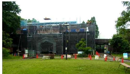
展示館屋根葺き替え工事
