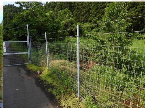
山際や移動経路の分断に電気柵や恒久柵（電気柵併用）の設置
